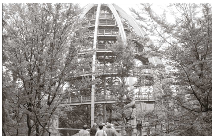
Der Baumwipfelpfad ist eine sehenswerte Konstruktion der Firmen WIEHAG und Metallbau Stadler.
