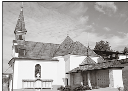
Die Familienkapelle nach der gelungenen Trockenlegung und Außenrenovierung
